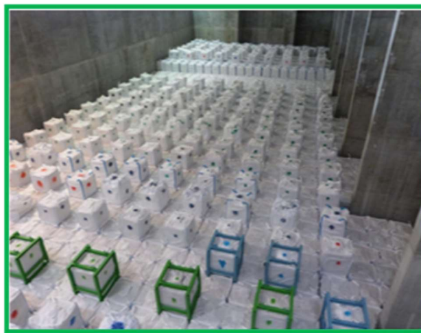
Vues du site de Creys-Malville et de la mise en entreposage des blocs sodés pendant la phase de fabrication
