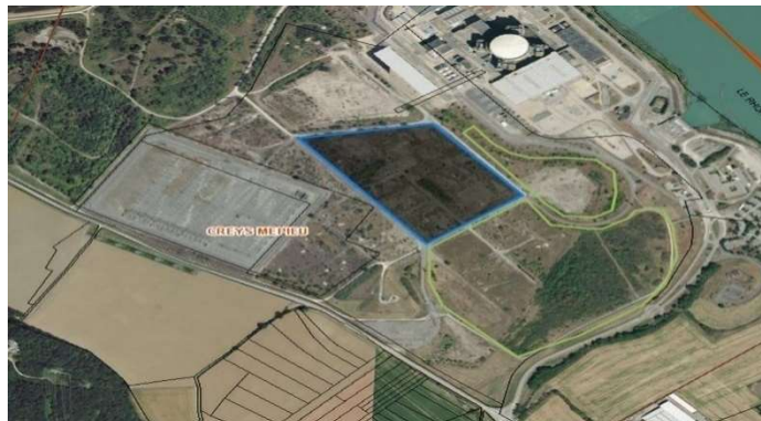
Vue aérienne de la zone d'implantation
