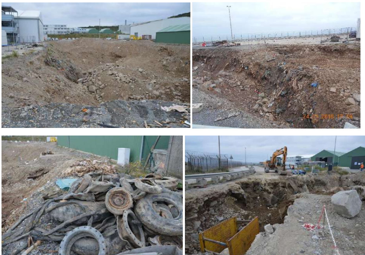
Figure 4 : Photographie de la zone de dépôts historiques de déchets lors des travaux d'aménagement au nord de la zone d'étude en 2017
