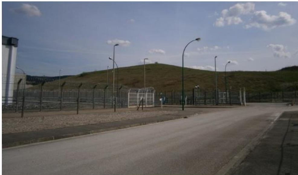
Vue de la butte du site de Bugey - Partie Ouest
