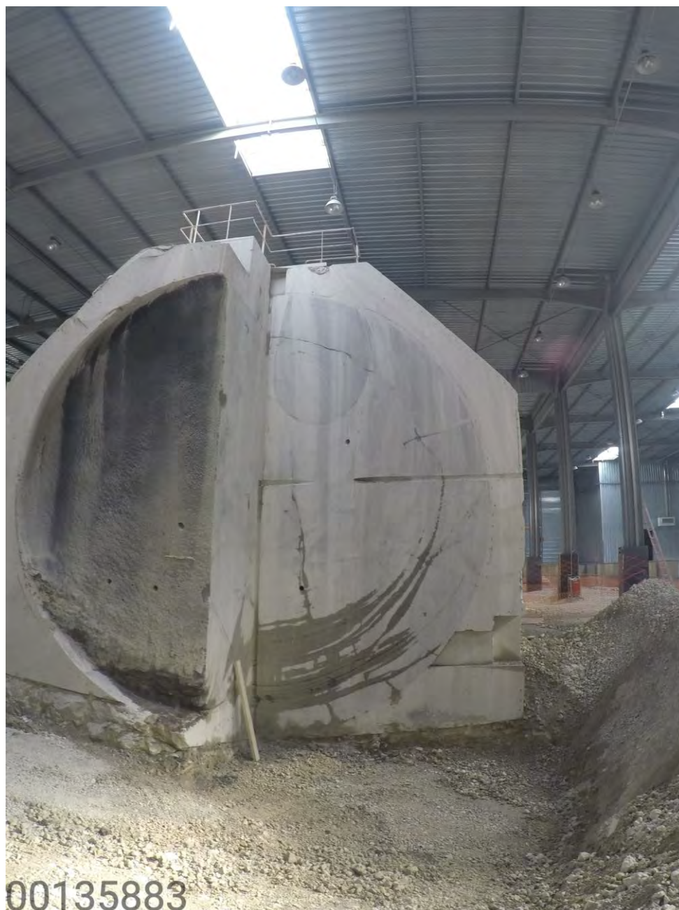
Figure 2-38 Exemple de déconstruction par sciage au câble du massif d'appui en béton d'un scellement (essai prototype FSS)
