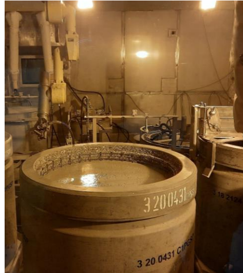
Panier de déchets calé par du coulis cimentaire dans une coque en béton C1PG
