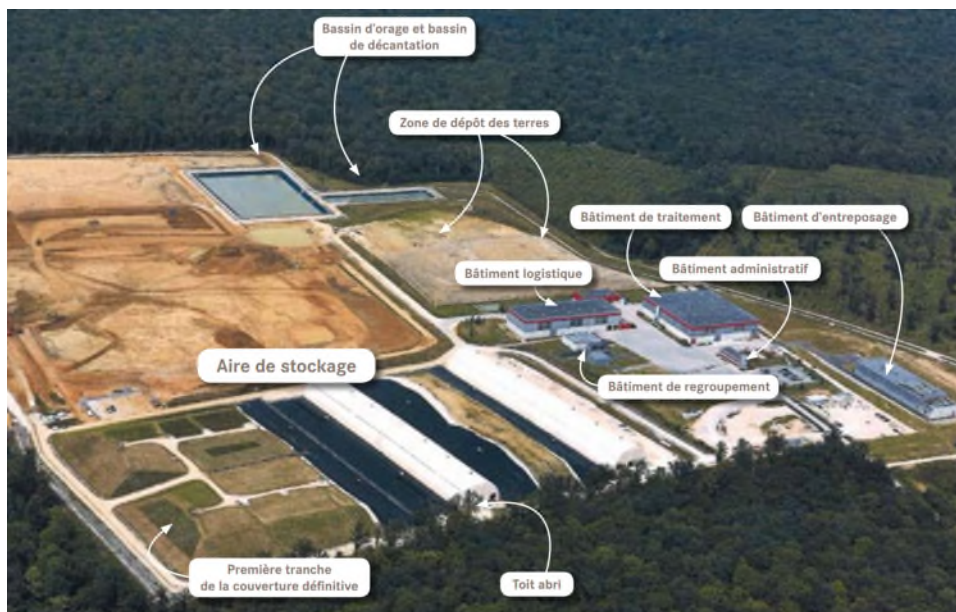
Vue aérienne du Cires (Source Andra)
